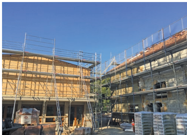
Installation des panneaux solaires.
