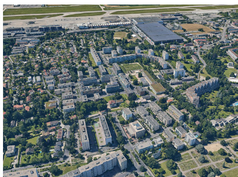
Fig. 180 : Le Pommier, la Tour, les Fins, Palexpo et l'aéroport (source : Google Earth)
