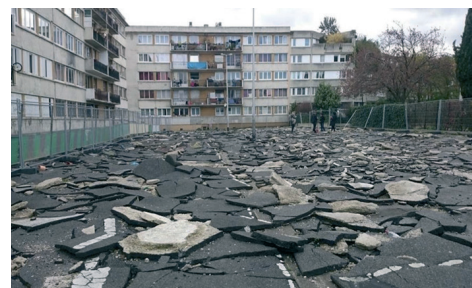
Fig. 75 : Faire d'un chantier un événement artistique.
