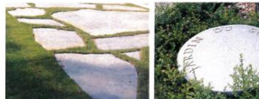
Grandes dalles béton avec joints enherbés. Jardin du souvenir intégré au massif.
